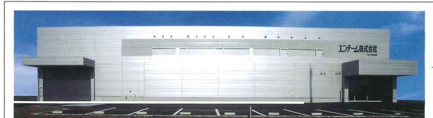
敷地面積 約3400㎡ 建物面積 約1300㎡(2階建て) ○主な設備 真空乳化工装置(300kg、50kg対応)、移動式原料溶解槽(200kg対応)、超高速移動式懸垂型ホモミキサー、半自動充填機、クリーム充填機、打栓機、キャッパー、エア洗浄機、印字機、シュリンクトンネル
